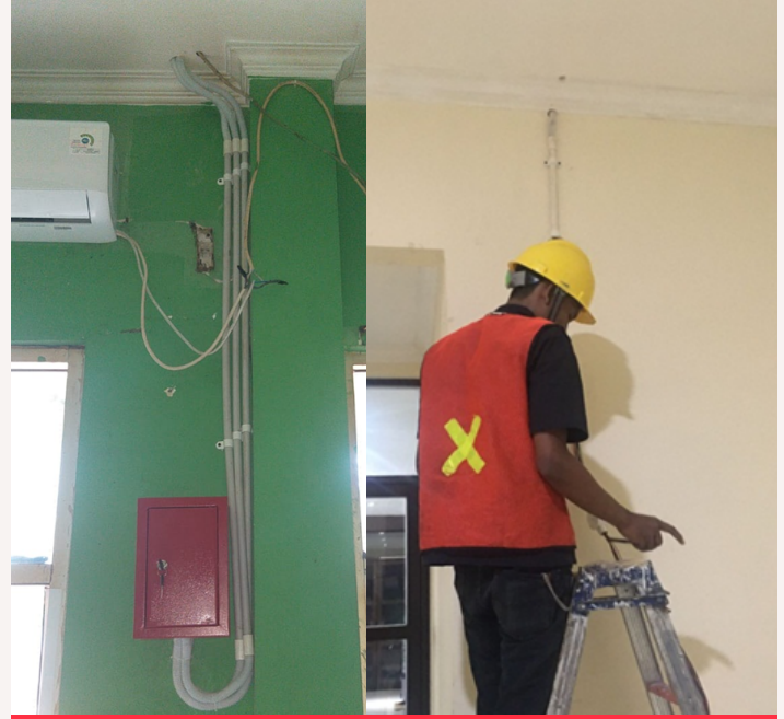
PEMASANGAN FIRE ALARM SYSTEM DI ULP BABELAN
