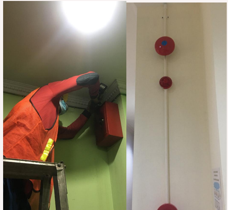
PEMASANGAN FIRE ALARM SYSTEM DI ULP MUSTIKA JAYA
