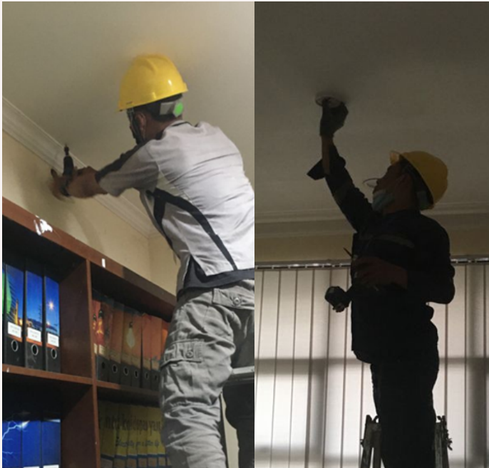
PEMASANGAN FIRE ALARM SYSTEM DI ULP MUSTIKA JAYA
